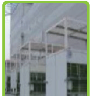
エアコン室外機の噴霧冷却による能力低下対策
