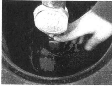
手順④: 止水のときはしっかりとボールバルブを閉栓してからライザー管を外す
