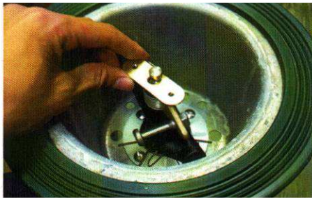
③ フタとスプリンクラーを固定しているプレートを外す。 この時点でケース内部に溜まった土砂を掻き出しておく。
