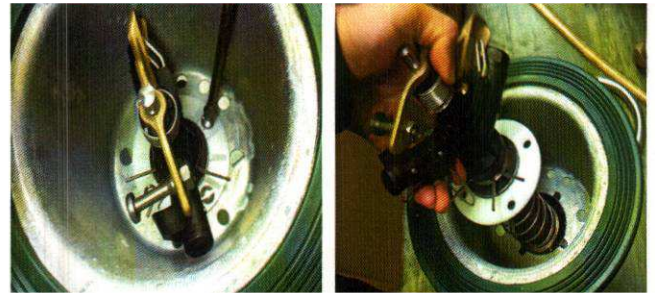
④ ケースとスプリンクラーを固定している4つのボルトを外し、スプリンクラーを引き抜く。
