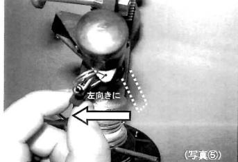
ポップアップスプリンクラーを取り付ける時には、 取り付け前に一度水を通水するなどして、配管の ゴミを取り除いてから取り付けてください。 この作業を怠りますと、スプリンクラーが回転しな かったり、回転が遅かったり、散水飛距離が落ちる などの不具合が生じます。最近、このような トラブルが多発しておりますのでご注意ください。
